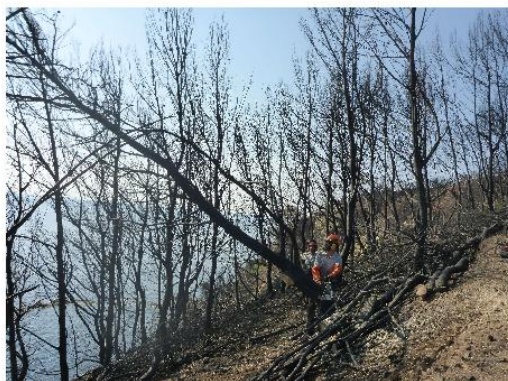
Illustration 1: Travaux d'abattages d'arbres dangereux
